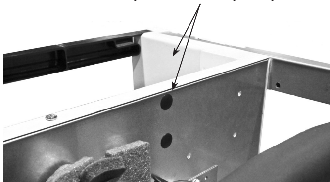
Снимите пластиковые заглушки с перегородок отсеков испарителя и компрессора
